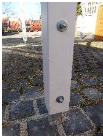
Stützenfuß einbetoniert
