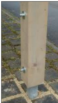
Stützenfuß einbetoniert
