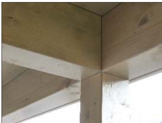
Quer- und Längspfetten mit verdeckten Holzverbindern an Stütze angeschlossen
