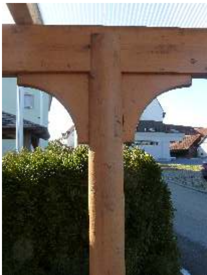
Gedrechselte Rundstützen mit Vouten an Pfette angeschlossen
